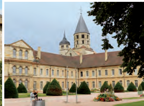
Reconstruits au XVIII e siècle, les bâtiments abbaciaux de Cluny abritent l'École des arts et métiers. À l'arrière, les tours de l'Eau-Bénite et de l'Horloge.
