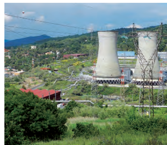
Deux des tours de refroidissement de la "Vallée du Diable" qui transforment les "soufflards" en énergie.
